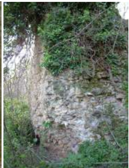
Figura 5 Parte del muro perimetrale
