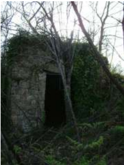
Figura 3 Ingresso alla cisterna
