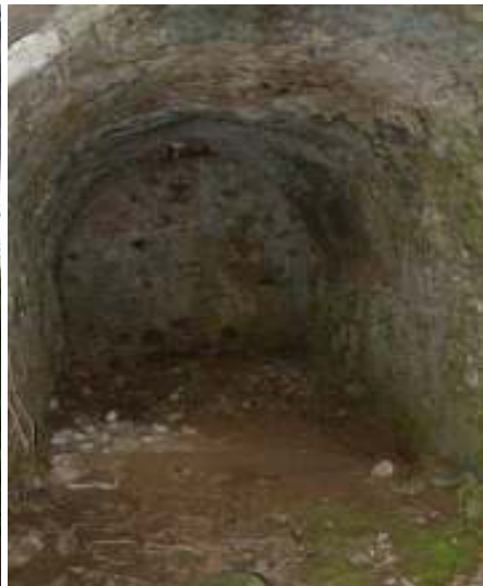
Figura 4 Interno della cisterna
